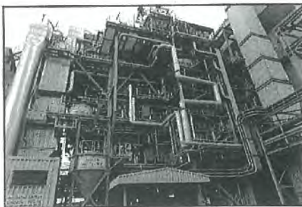
อาคารหม้อไอน้ำ (Boiler) ขนาด 42.5 ตัน/ชั่วโมง
