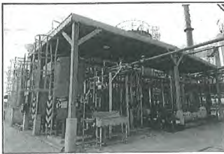
ระบบผลิตน้ำ เข้า boiler
