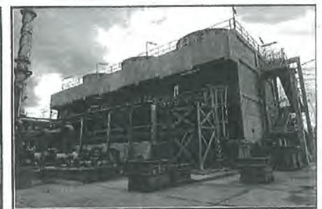
หอหล่อเย็นเครื่องกังหันไอน้ำ (Cooling tower)
